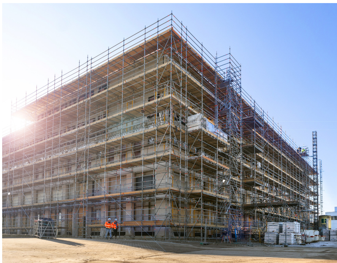
De nieuwbouw vordert snel.
